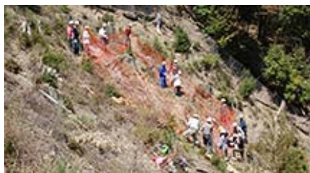
古くなった階段の補修作業
