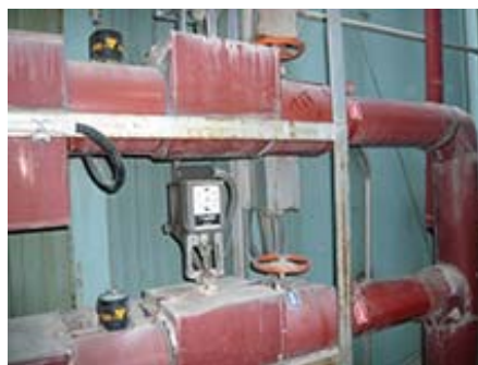
養生槽にストップバルブ設置
