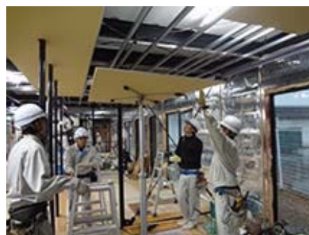
「内装施工コース」の天井石こうボード施工実習
