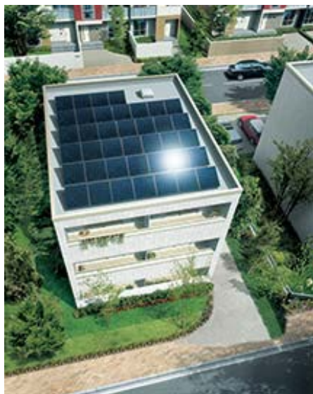
据え置き型太陽光パネル
