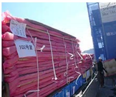
内壁枠への世帯番号表示。10の部材群に対し、積載山や部材への世帯番号表示を実施するようになり、部材の仕分けや間配り作業の効率が格段に向上しました
