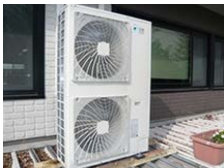
空調設備の更新
