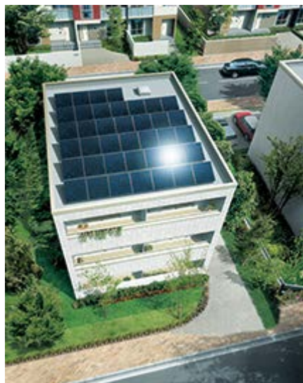
据え置き型太陽光パネル
