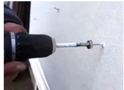
インパクトドライバーを逆回転させ、ビスを引き抜く
