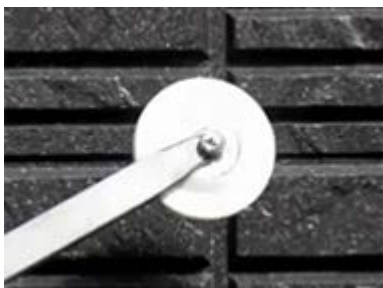
「バックアップ材充填ローラー」
