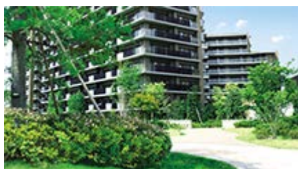
センターツリー周辺
