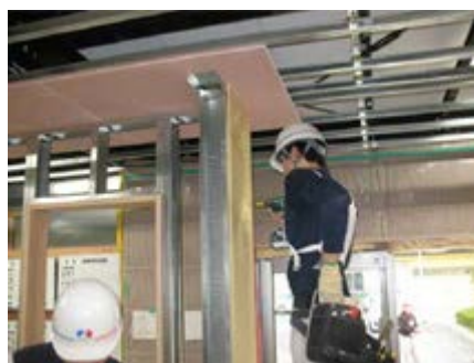
「内装施工コース」修了実技試験
