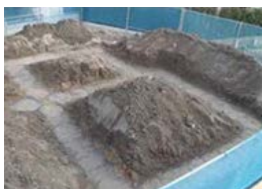
戸建住宅での施工例
