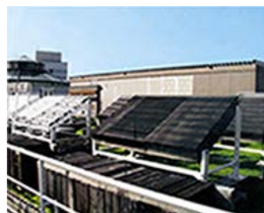
暴露試験を実施しています
