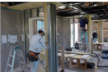
内装施工コース 修了試験風景
