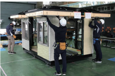
躯体外装コース 修了試験風景
