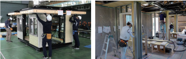
躯体外装コース 修了試験風景
