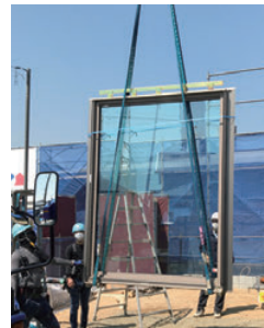
シャードッド大型FIXサッシ複合工法
