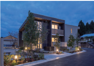
熊本県山都町 定住促進住宅外観
